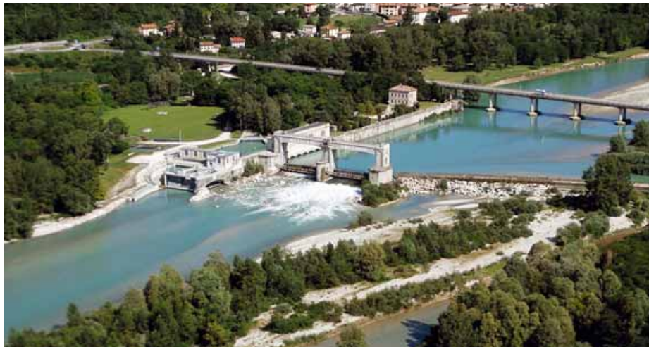
Veneto. Consorzio di bonifica Piave. All'interno dell'impianto del canale Brentella è stata realizzata la centrale idroelettrica Fener che, attraverso la derivazione delle acque del bacino, produce energia elettrica pulita
